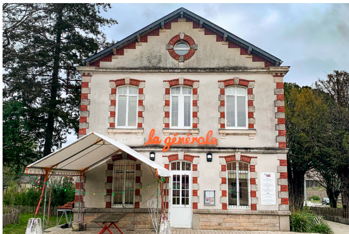
BATIMENT DE LA GÉNÉRALE
